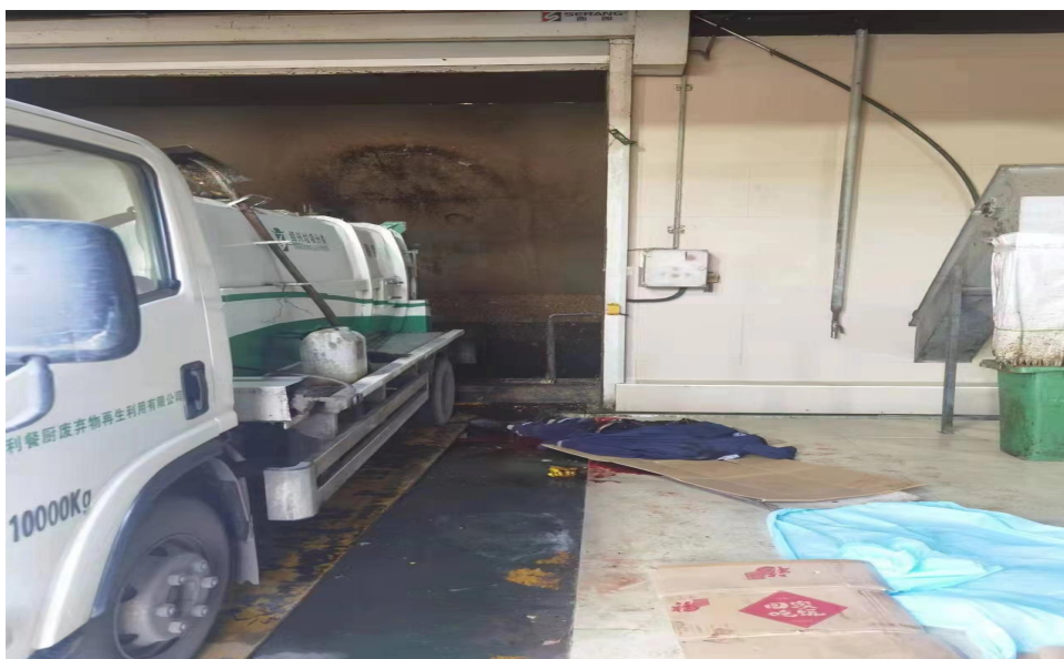
图 4 事发卸料口现场图
